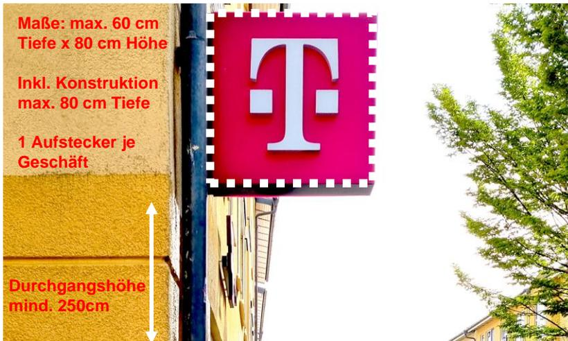
Abb. 12: Bemaßung und Ausrichtung von Werbeanlagen (Aufstecker) in der Havelpassage
